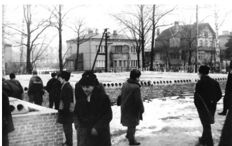
Budowa przedszkola przy ul. Boh. Salingradu (Zamkowej)
