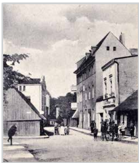
Początek XX w. Neustrasse, czyli współcześnie ulica Sienkiewicza - po prawej stronie widoczna kamienica Alberta Pisulli.
