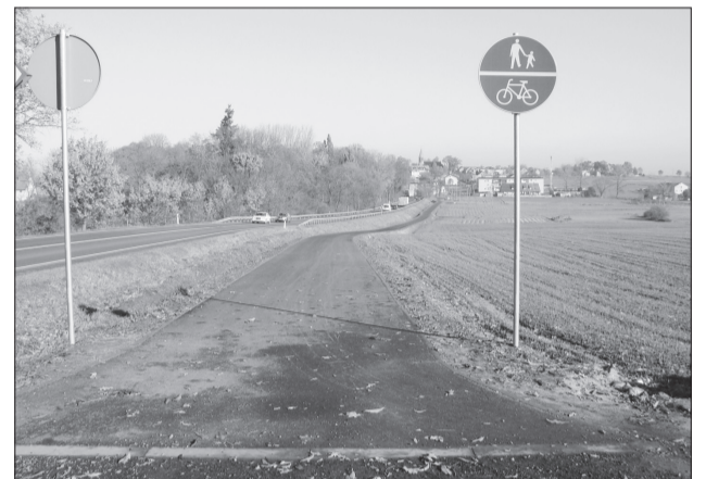
Mieszkańcy Rogaszyce doczekali się ciągu pieszo – rowerowego wzdłuż drogi krajowej nr 11.
